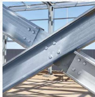
Металлокаркас здания выполняется из ряда рам, состоящих из колонн постоянного сечения и элементов покрытия.
